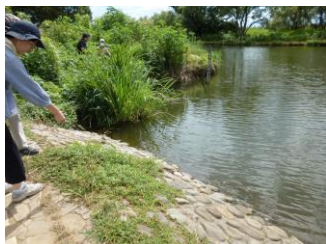
地点2 大堀川 北柏ふるさと公園護岸東端
